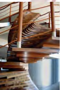
Escalier intérieur en lamellé-collé de Jarrah - Les Bois du Pacifique - Nouméa (Nouvelle-Calédonie)
