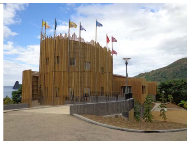
Pin des Caraïbes (Caribbean Pine) Bardage résille de la Mairie de Hienghène - Nouvelle-Calédonie (Slats cladding on the Hienghène City Hall - New Caledonia
