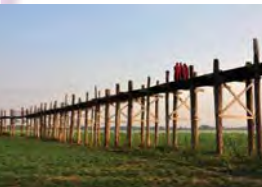
Pont d'U Bein (le plus long pont en Teck du monde, 1200 mètres, construit en 1849 avec des billes récupérées lors d'un déménagement d'une cité royale) - Mandalay (Birmanie)
